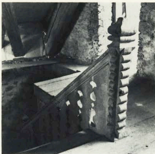
Abb. 15 Treppengeländer aus der Bauzeit von 1722 im Estrichbereich.
